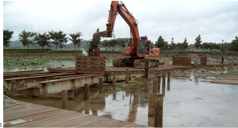
1.2.3.4.5.6 연꽃탐방로 시공 과정
